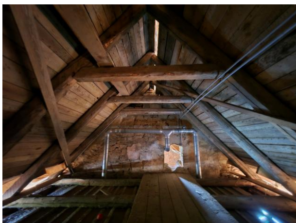
14. fotó: A hajó feletti torokgerendás fedélszék
