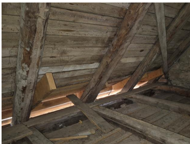
39. és 40. fotók: Szarufa ferde lefutású repedése
