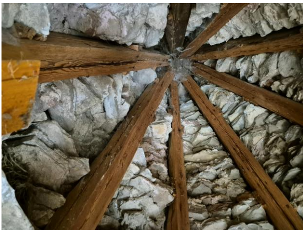
46. és 47. fotók: A toronysisak belső felülete (sugárirányú fagerendák és fa merevítő szerkezet)
