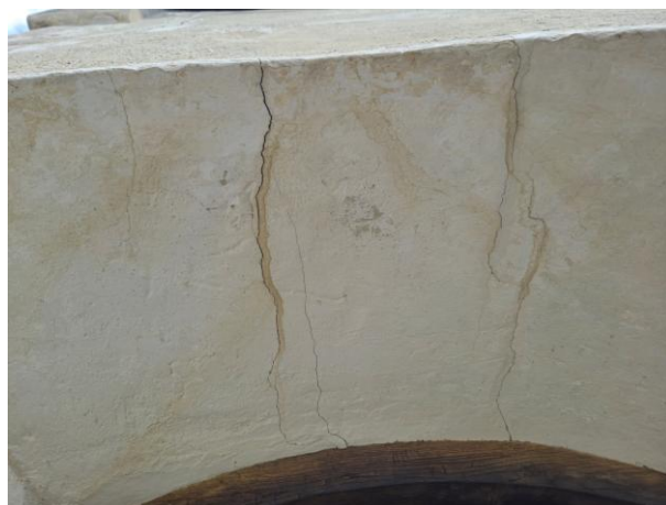
31. és 32. fotók: A templom bejárata feletti boltozaton lévő repedések (a 05. számú repedés)
