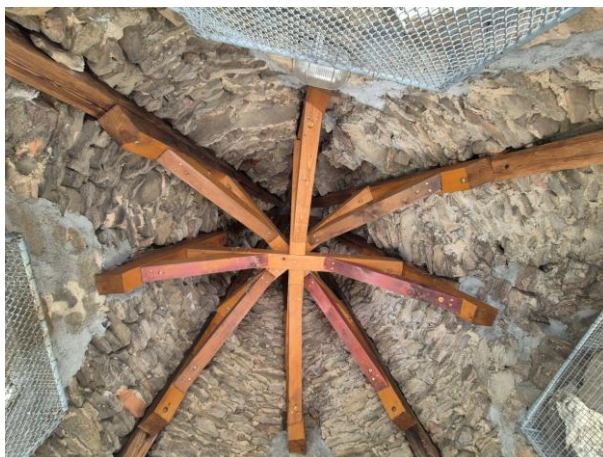
16. fotó: A sisakot alátámasztó és merevítő faserkezetek.
