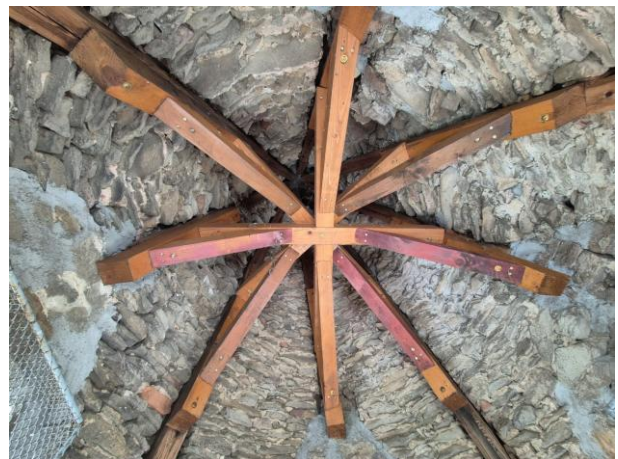
46. és 47. fotók: A toronysisak belső felülete (sugárirányú fagerendák és fa merevítő szerkezet)
