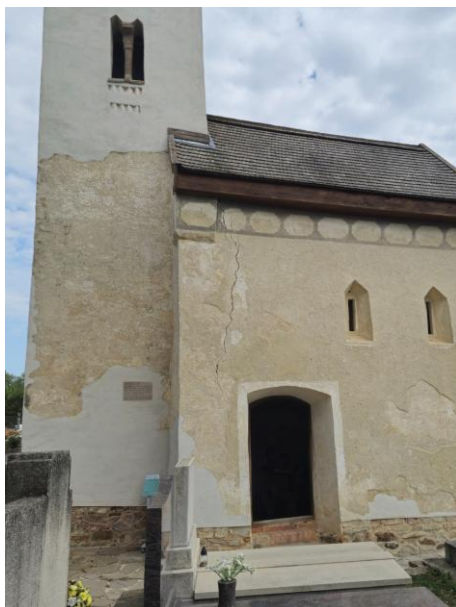
19. és 20. fotók: A 01. számú repedés a helyszíni szemle idején (külső és belső fényképek)
