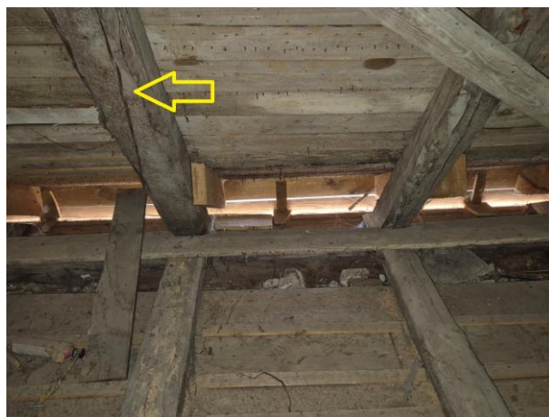
39. és 40. fotók: Szarufa ferde lefutású repedése
