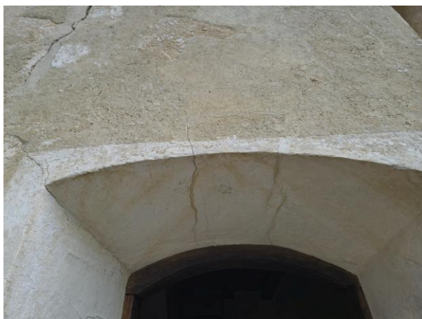
31. és 32. fotók: A templom bejárata feletti boltozaton lévő repedések (a 05. számú repedés)
