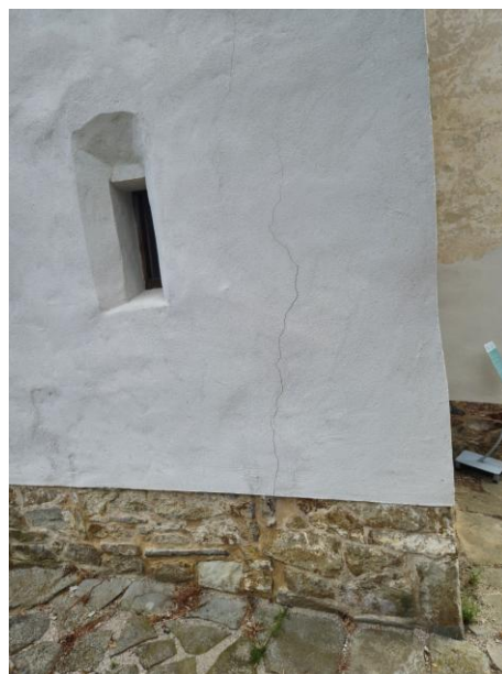
26. és 27. fotók: A 03. számú repedés (a 2014-es felújítás utáni és a jelenlegi állapot)
