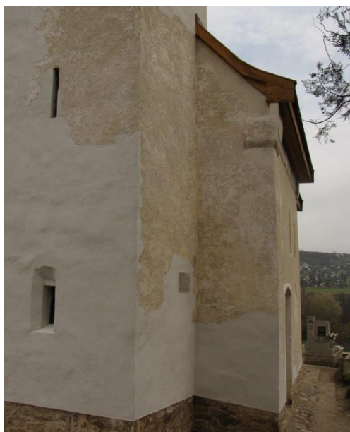
26. és 27. fotók: A 03. számú repedés (a 2014-es felújítás utáni és a jelenlegi állapot)
