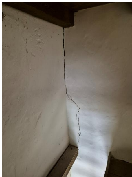
24. és 25. fotók: A 02. számú repedés a helyszíni szemle idején (külső és belső fényképek)
