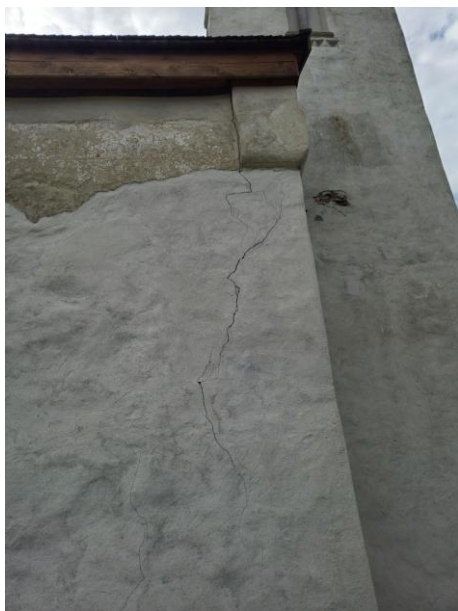
24. és 25. fotók: A 02. számú repedés a helyszíni szemle idején (külső és belső fényképek)
