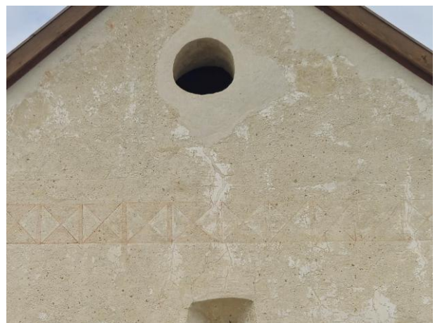
29. és 30. fotók: A 04. számú repedés (a 2014-es felújítás utáni és a jelenlegi állapot)
