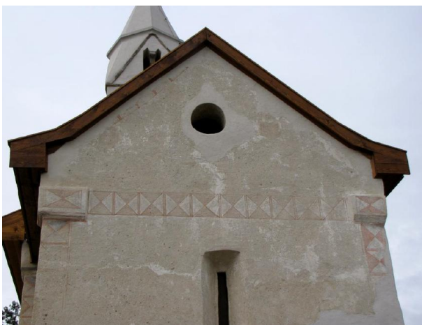
29. és 30. fotók: A 04. számú repedés (a 2014-es felújítás utáni és a jelenlegi állapot)
