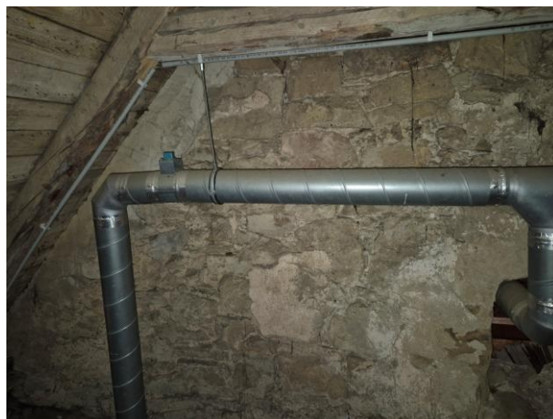
44. fotó: A fedélszék elemeihez rögzített szellőzőcsövek
