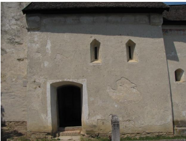
17. és 18. fotók: A 2014-es felújítás előtti, valamint utáni állapot (01. számú repedés)
