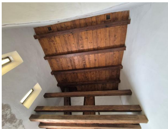
11. fotó: A hajó fagerendás síkfödémje és a karzat szerkezete
