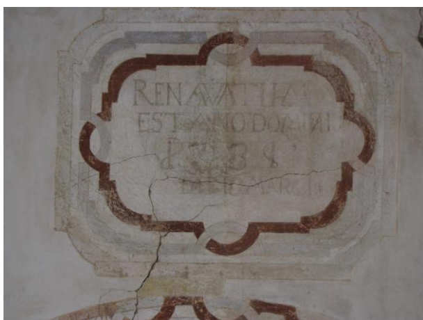
33. és 34. fotók: A 06. számú repedés (balra) a restaurálás után nem jelent meg újra (jobbra)
