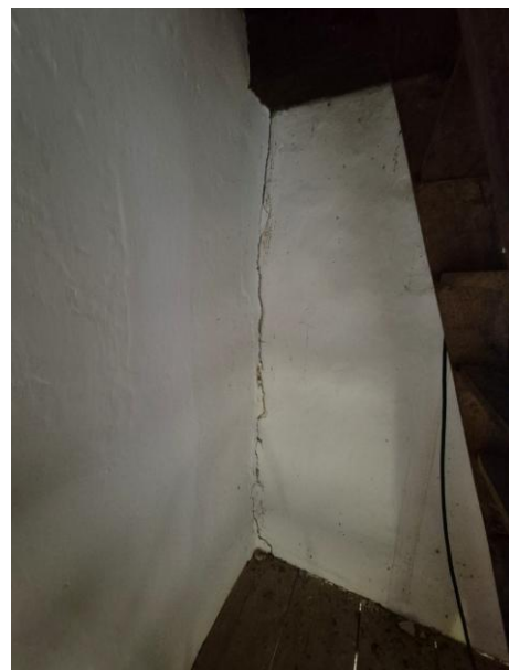
19. és 20. fotók: A 01. számú repedés a helyszíni szemle idején (külső és belső fényképek)
